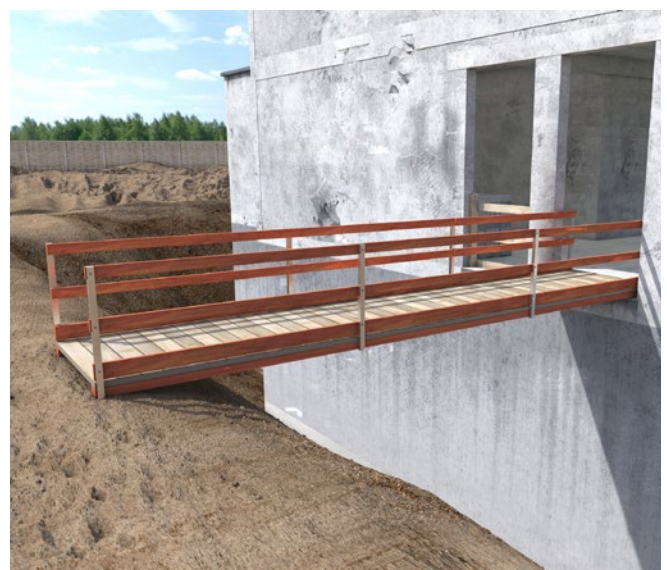
Abb. 3.5.2-03 Laufsteg mit Seitenschutz als Verkehrsweg
