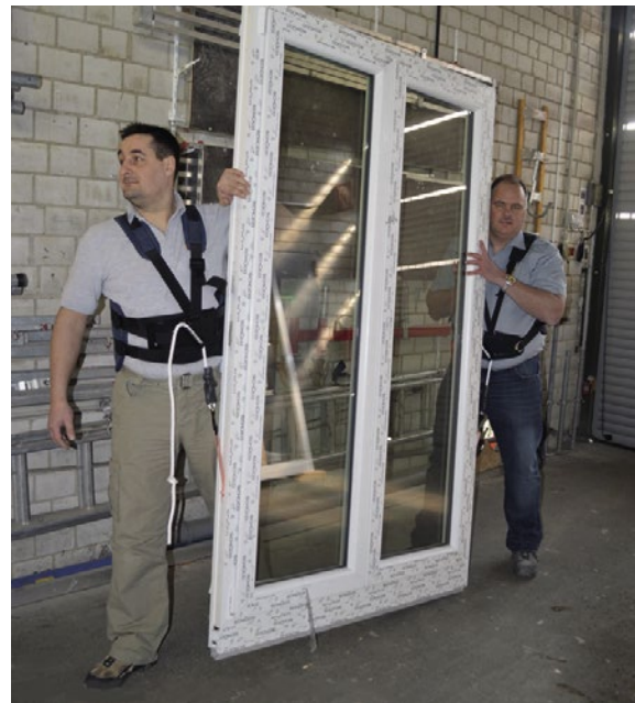
Abb. 3.4.5-04 Transport mit Hilfe von Tragegurten
